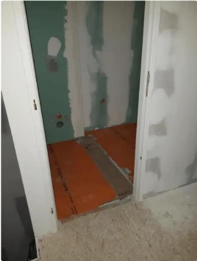
AVANT - Pose d'une natte Schlüter sur OSB
