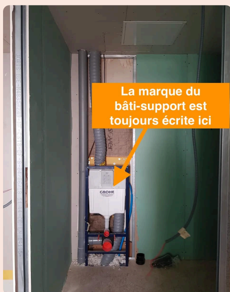
Marque bâti-support visible avant placo
