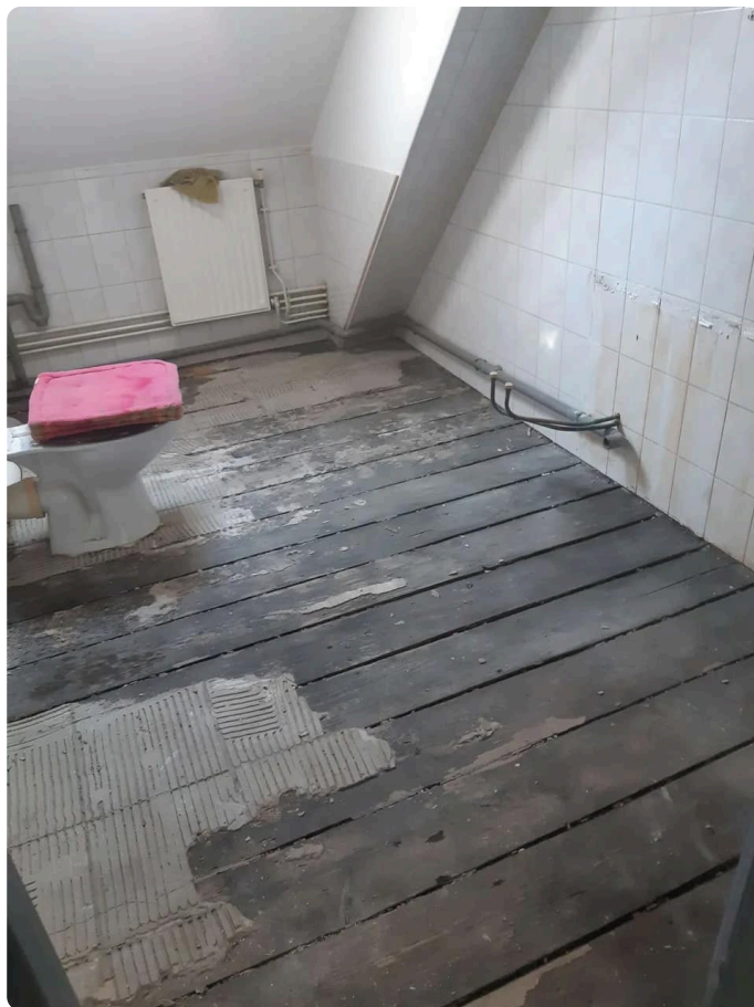
Retirer le carrelage et la colle pour mettre le plancher bois à nu
