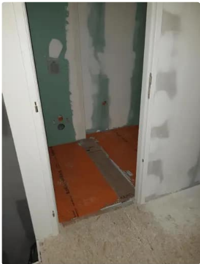
AVANT - Pose d'une natte Schlüter sur OSB
