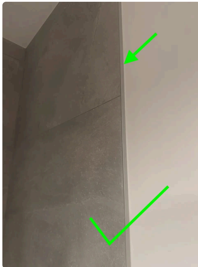
Ci-dessous un exemple de finition de carrelage avec profilé :
