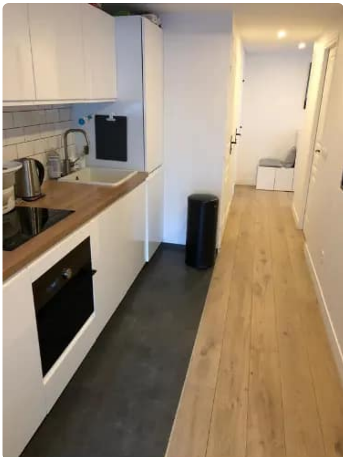
Photo : jonction carrelage/parquet avec profilé aluminium (carrelage effet béton anthracite ALMA Leroy Merlin)
