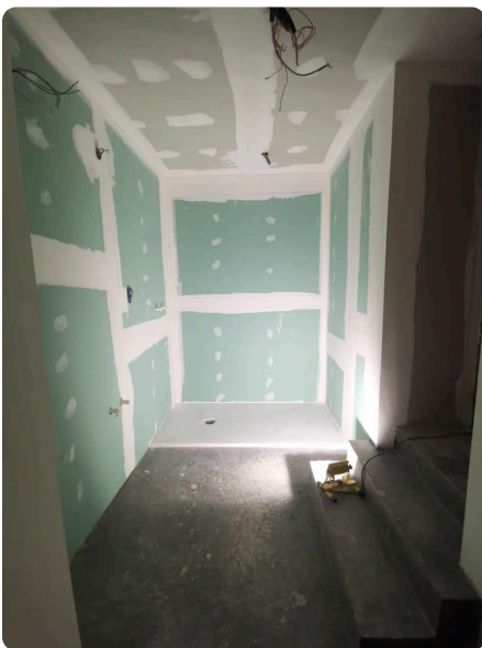
Avant la mise en place de l'étanchéité
