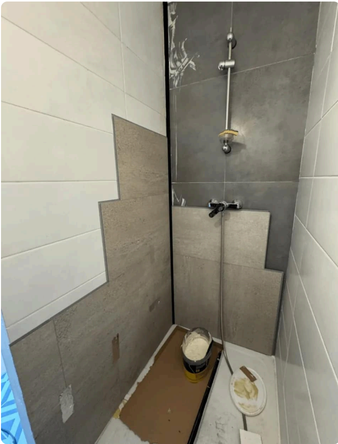
Pendant la pose des panneaux Dumawall
