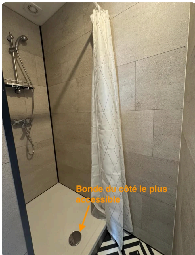
Exemple d'une bonne pose avec la bonde facilement accessible en cas de fuite
