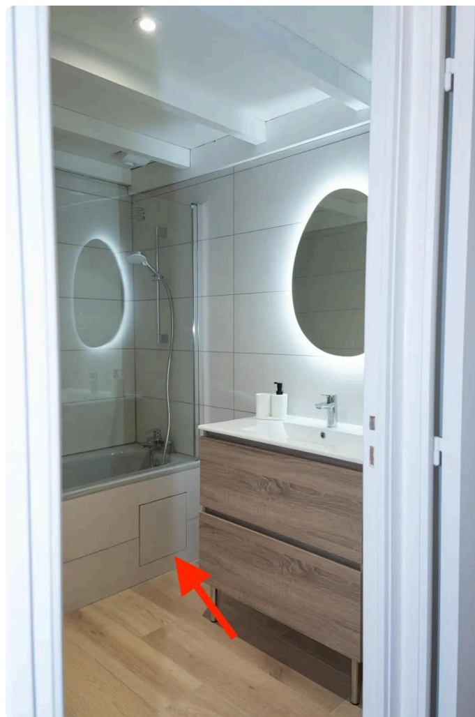
Exemple photo trappe accès bonde baignoire
