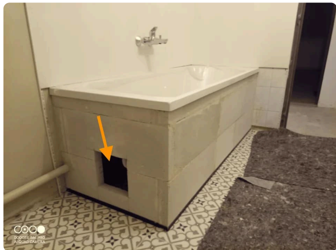
Exemple photo trappe accès bonde baignoire avant carrelage
