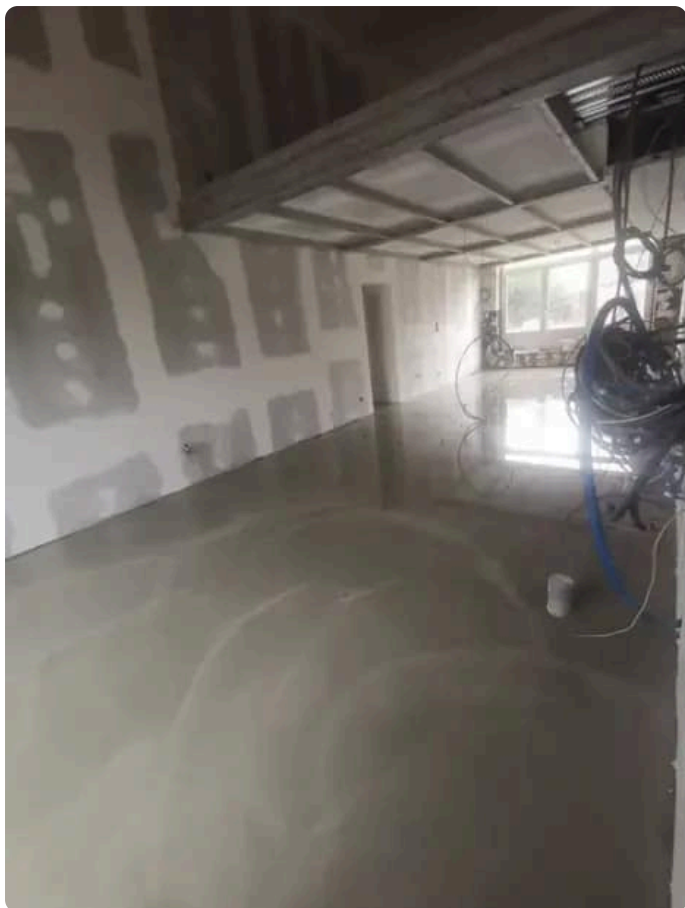
Étape 3 : mise en place rapide du ragréage
