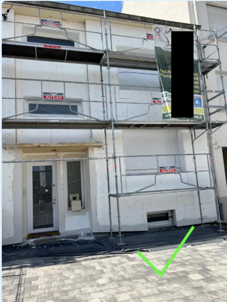
Ébrasements isolés et panneaux chevillés
