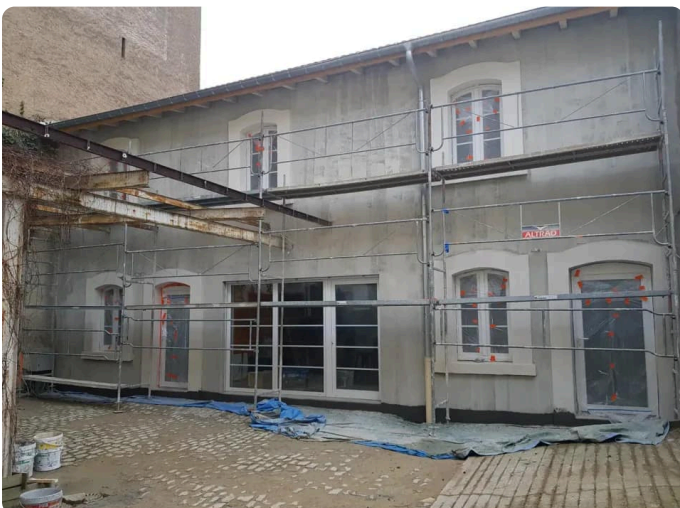
5. Agrafage des fissures si nécessaire, puis première couche
