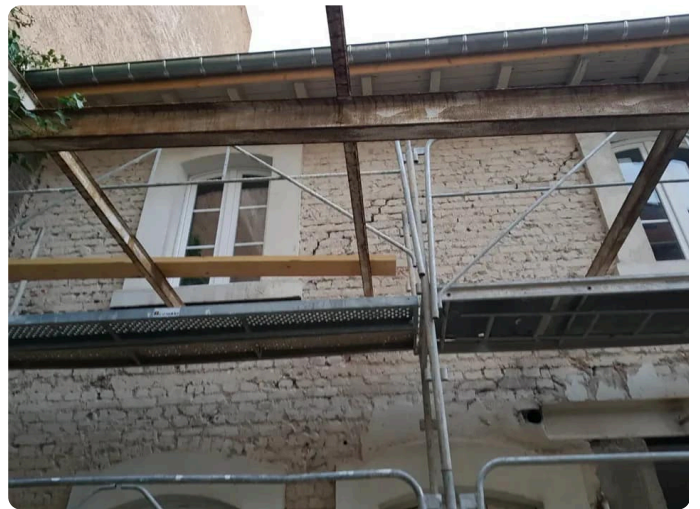
4. Décrépissage de l'ancien enduit
