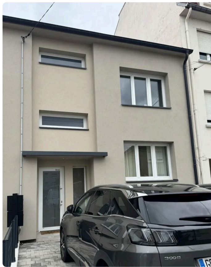
Après les travaux
