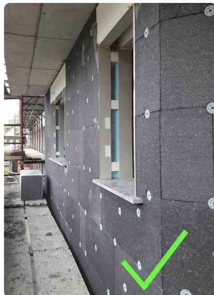
✅ Retour d'isolant sur l'ébrasement
