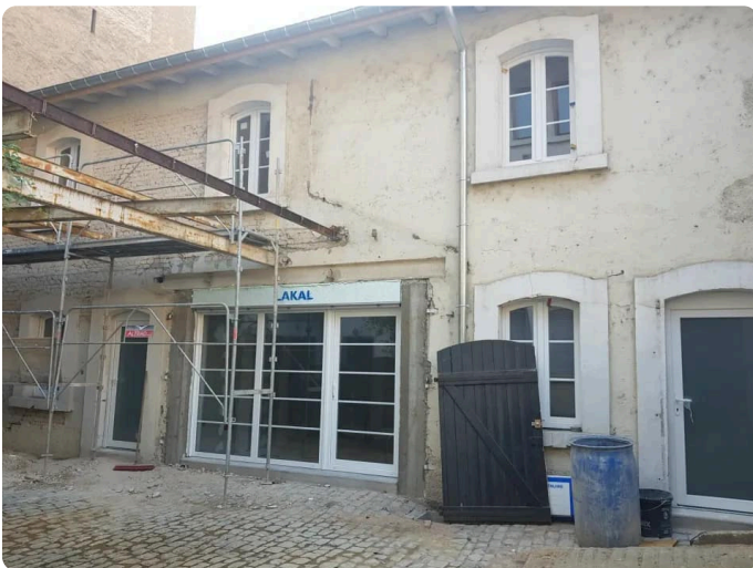
3. Pose des menuiseries extérieures
