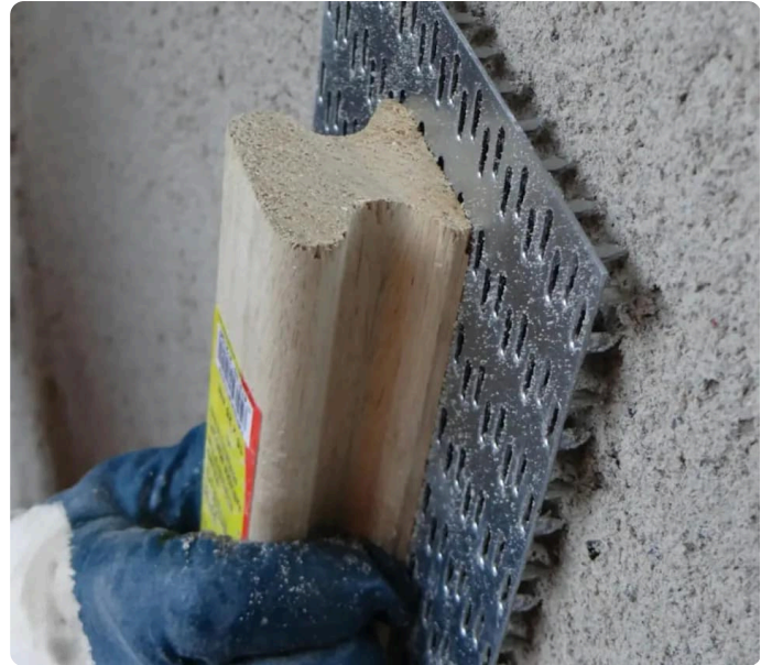
La finition grattée ajoute une étape après la projection
