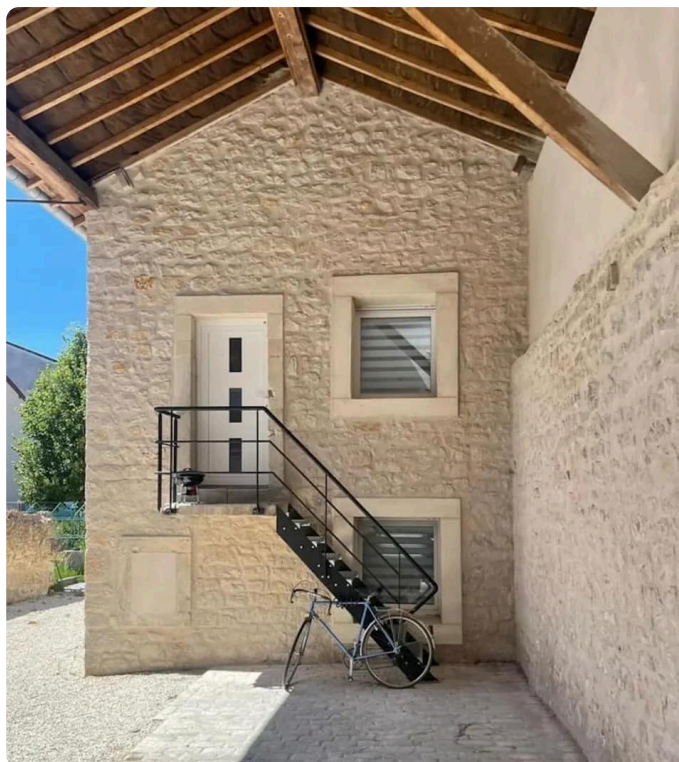
Après : pierres rejointoyées à la chaux
