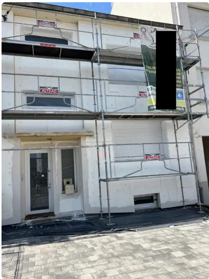
Pendant les travaux
