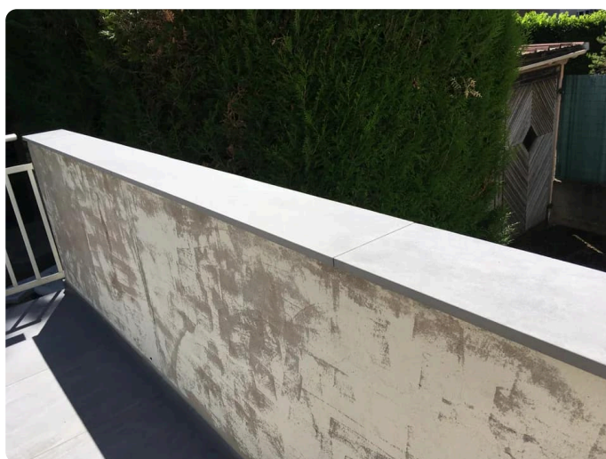
Étape 12 - Pose du carrelage sur le dessus du muret
