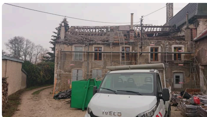
Dépose de la couverture existante, des chevrons, des pannes et des liteaux
