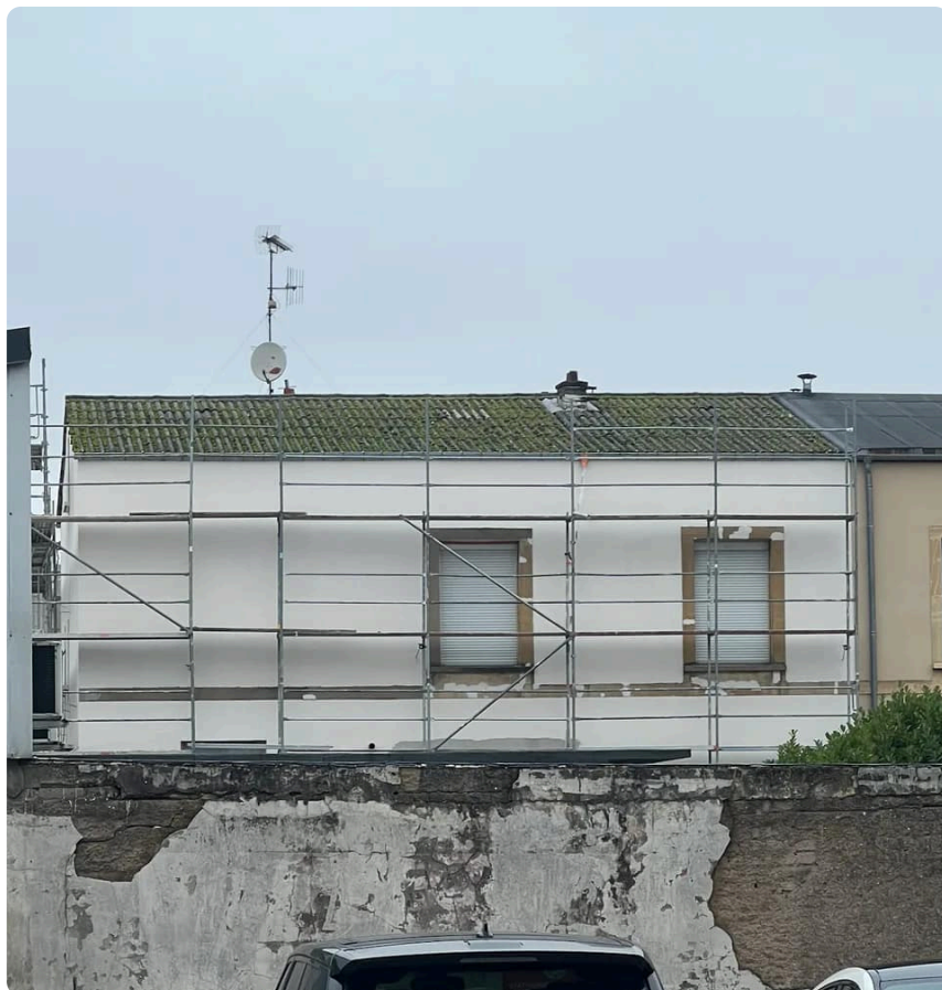
Photo de la toiture avant les travaux
