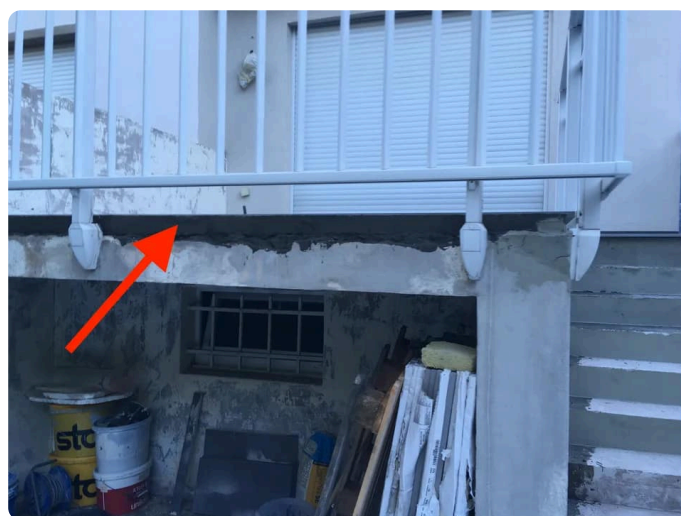
Étape 6 - Traitement de l'étanchéité sur le bord de la terrasse
