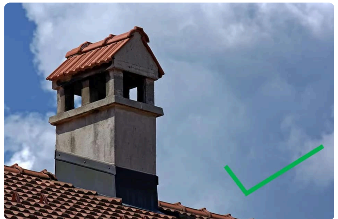
Abergement métallique correctement réalisé
