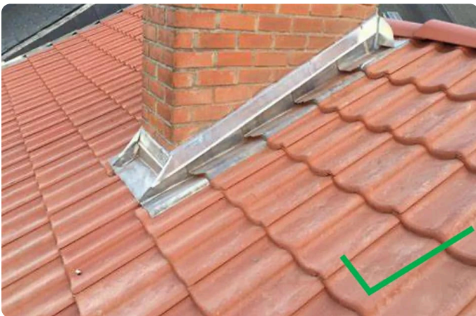
Solin métallique correctement réalisé
