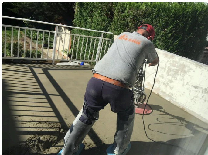
Étape 3 - Si nécessaire, mise en place d'une chape ou ragréage
