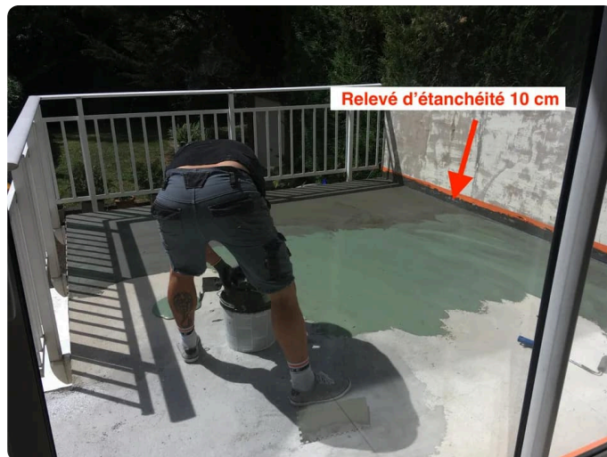
Étape 4 - Application d'une étanchéité avec relevé de 10 cm en pied de mur
