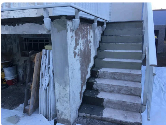
Étape 5 - Application de l'étanchéité sur les marches de l'escalier
