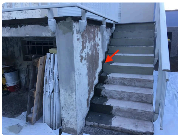
Étape 8 - Pose du carrelage sur les marches de l'escalier
