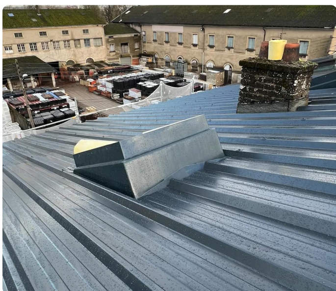
Velux surélevés car la pente est inférieure à 20°
