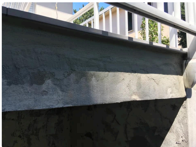
Étape 10 - Débord du carrelage en rive pour protéger le chant de la terrasse
