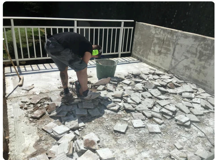
Étape 2 - Dépose de l'ancien carrelage et mise à nu du support
