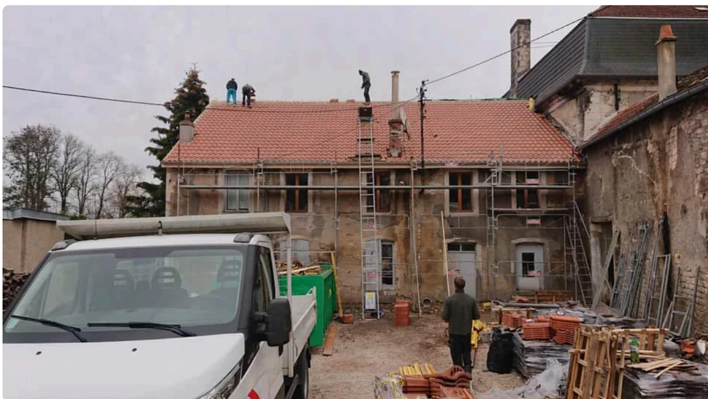
Pose de la couverture, de la zinguerie et des solins
