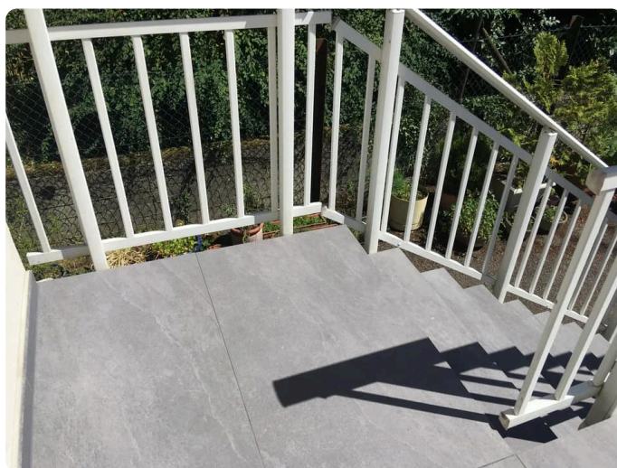
Résultat final de l'escalier carrelé
