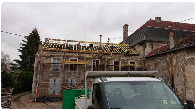
Pose de nouveaux chevrons et de nouvelles pannes
