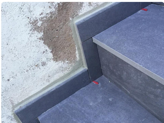
Étape 9 - Traitement de l'étanchéité et préparation des plinthes le long de l'escalier
