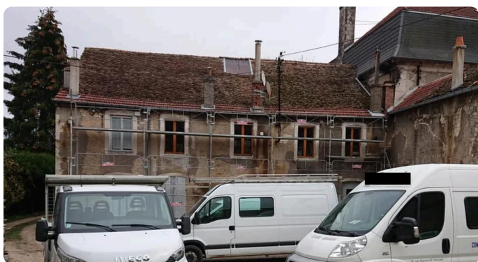
Toiture existante à rénover entièrement
