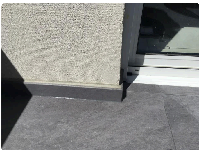
Étape 11 - Finition de l'étanchéité au niveau des plinthes et du seuil
