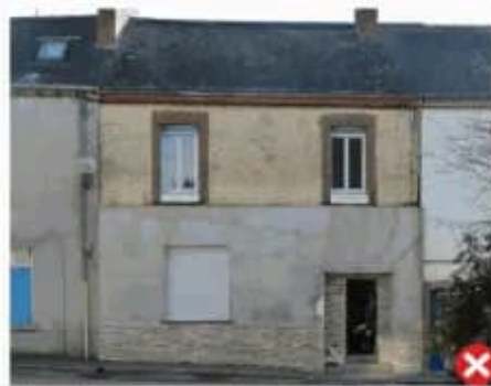
Disparition des proportions des baies du rez-de-chaussée, enduit-ciment et placage en fausses pierres inadéquats.
