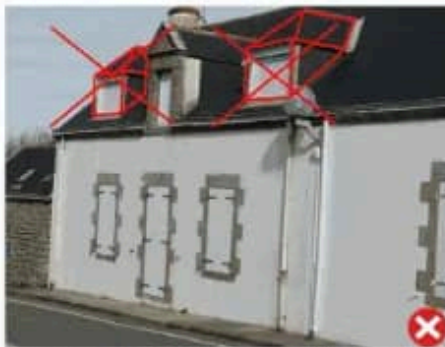
L'ajout de lucarnes, plus larges que hautes sur le pan de toiture déforme la volumétrie et alourdit la composition.
