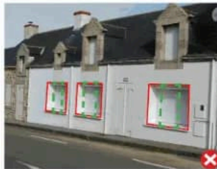
Les proportions des baies du rez-de-chaussée plus larges que hautes ainsi que les volets roulants amoindrissent l'harmonie de la façade.
